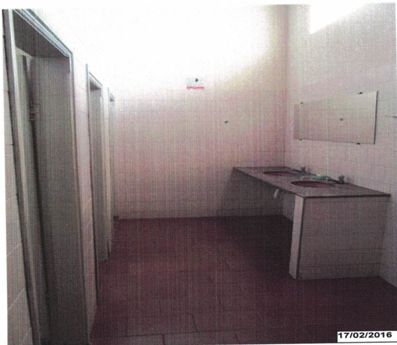
BANHEIRO DO SALÃO
